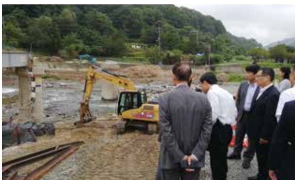
【被災箇所の現地視察（JR連合）】 関係単組とともに国会議員等に呼び掛け災害による鉄道被災現場を視察し、実態把握及び国政への反映を促している
