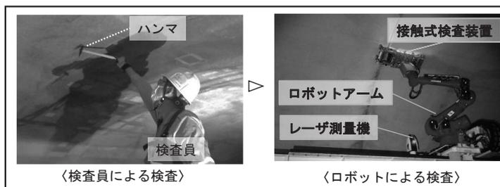
トンネル検査ロボットによる検査の自動化（出典：JR東海）
