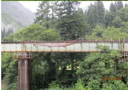
沿線の道路を自動車で行きつつ視察したが、山間や川・ダム湖のすぐそばを縫うように走る同路線は、極めて険しい地理条件下にあり、大きくえぐられた湖岸の軌道等の復旧にあたっては、行政による治山・治水はもとより河岸工事とあわせ大規模な土木工事が必至である。現地では、とりわけ流失して未復旧のままである第5～第7橋梁や、深くえぐられた路盤に衝撃を受けたが、冬季の豪雪の重みで破損した橋梁設備、生い茂る草木で見えなくなった軌道や信号設備など、被害
