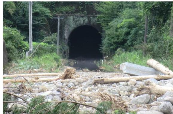
▲筑前岩屋駅のトンネルは冠水し線路上には流木などが大量に散乱している。
