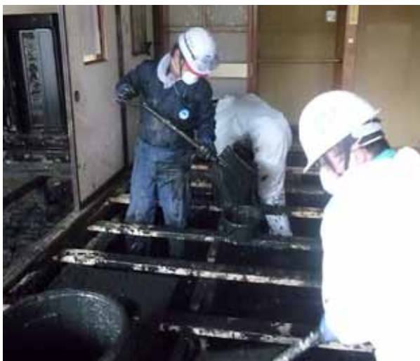
被災者宅で床下の堆積したヘドロを撤去する
