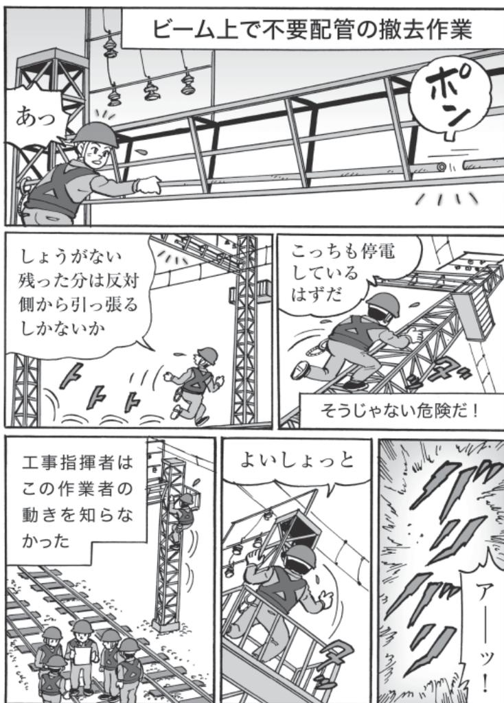
当該の作業員は、夜間作業で、電柱上のビームの不要配管を撤去していました。架線（トロリー線）は停電していましたが、電柱上の高圧配電線は、片側は停電、もう片側は通電状態にありました。もともと通電側での活線近接作業の予定はなく、電気作業用の保護具は着用していませんでした。通電箇所・停電箇所の確認も不十分だったといえます。
