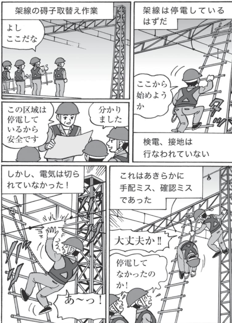
当日はE駅構内で停電手配により碍子取替作業を行う予定でした。工事指揮者は、事前にJR側と停電手配の打合せをした後に作業計画を一部変更しましたが、これがJR側にうまく伝わっていませんでした。工事指揮者は変更した作業箇所は停電していると思い込み、当該の作業者に指示しました。図面にも停電の印が書かれていましたが、実際には、その箇所は通電状態にあったのです。
