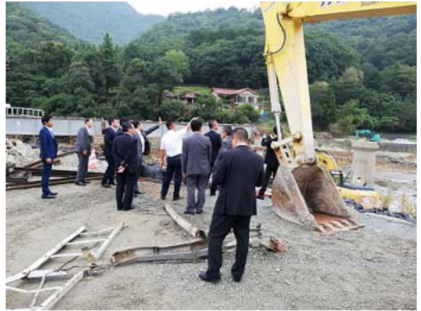
▲芸備線の第1三篠川橋りょうは過去にも被災し、補強された橋脚が残り、当時のままの橋脚が倒された。
