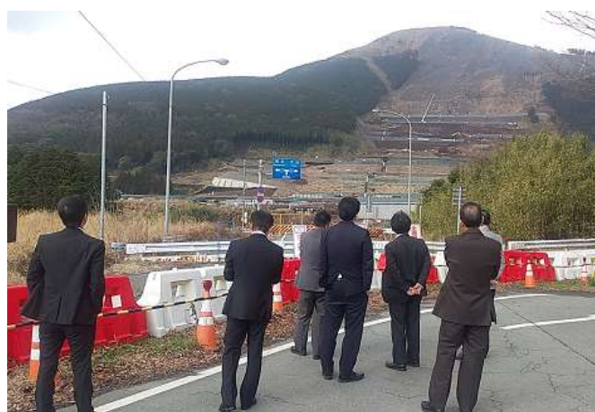
▲ 立野～赤水間の大規模斜面崩壊は、今でも規模の大きさが確認でき、いかに甚大な被害であったか想起される状況。
